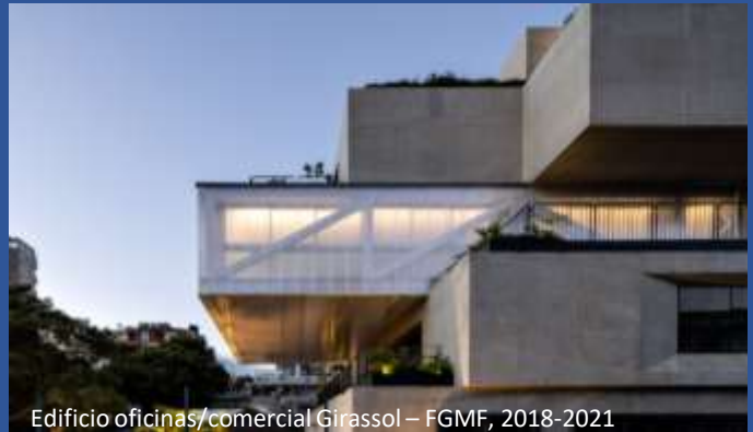
Edifício oficinas/comercial Girassol – FGMF, 2018-2021
